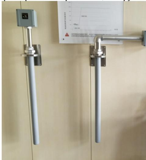
Нагреватели устанавливают в расширенные посадочные отверстия и подключают к шкафу управления ШУ-В1 (42 кВт). Для контроля температуры нагрева в нагреватели встроены термодатчики.
